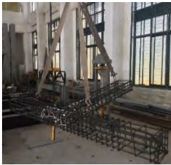
Hình 2. Chi tiết cốt thép
